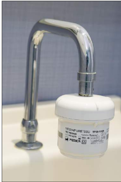
Figure 23 : Microfiltre d'eau au point d'usage
